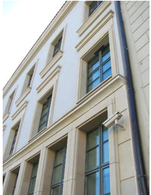
Boczna elewacja budynku ukazuje uporządkowany rytm otworów okiennych wykończonych kamiennymi obramieniami
