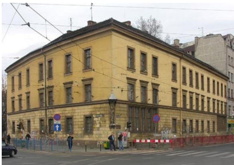
Budynek dawnego szpitala zrujnowany przez lata zaniedbań w stanie przed rozpoczęciem przebudowy
