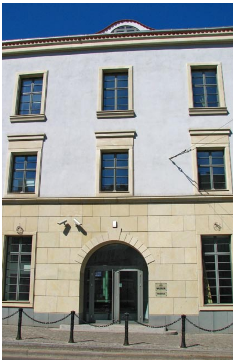
Tynkowany wysoki boniowany cokół zastąpiła okładzina z dolomitu, zachowując oryginalny charakter
